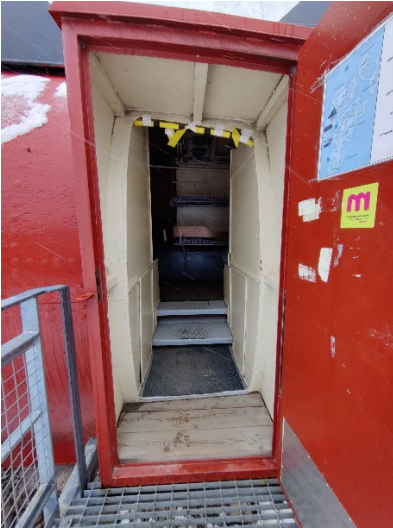
Kuva 2: Vesikon sisäänkäynti sisäpuolelta
