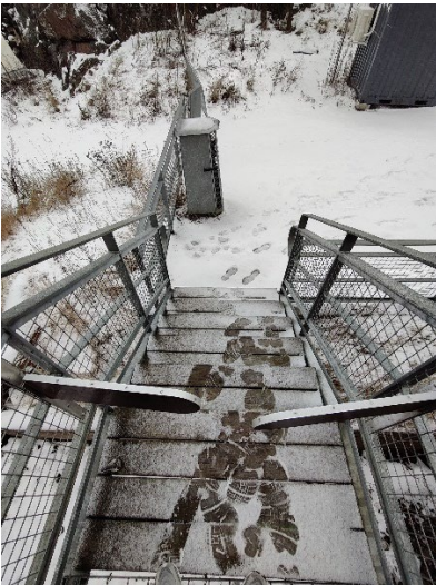
Kuva 6: Vesikon uloskäynnin portaat ylhäältä
