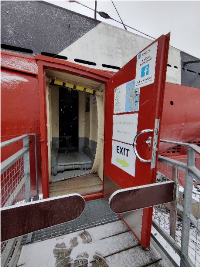
Kuva 5: Vesikon uloskäynnillä on poikittaispalkki 180 cm korkeudessa, joka aiheuttaa törmäysvaaran
